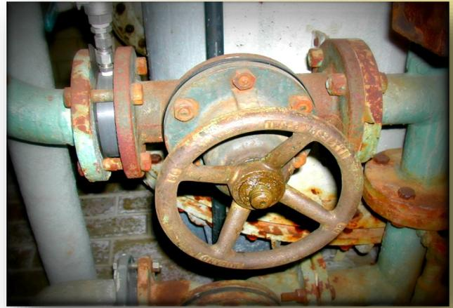
**GLI EFFETTI DELLA CORROSIONE POSSONO ESSERE DANNOSI: IMPLICANO LA RIDUZIONE DELLE RESISTENZE MECCANICHE DELL'ACCIAIO, CON EFFETTI SULLA SICUREZZA, SULL'AFFIDABILITA' DELLE STRUTTURE E SUI COSTI.**
